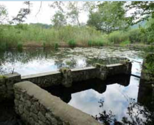
Le système de vannage a été consolidé et des murs en pierres restaurés.
