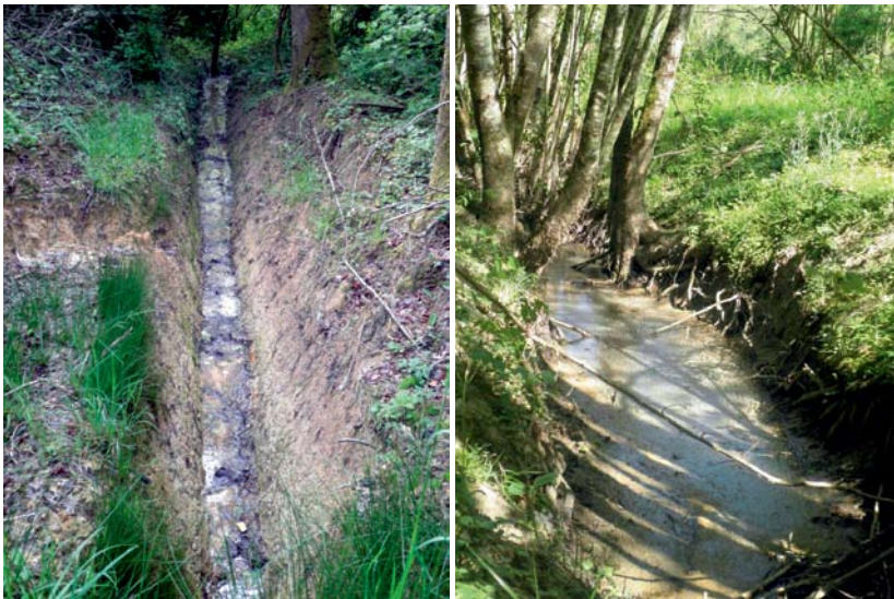
La forêt au dessus de l'étang est drainée : les fossés sont profonds, droits et pentus. L'écoulement de l'eau y est très rapide lors d'orages, ainsi l'eau monte vite dans l'étang.
