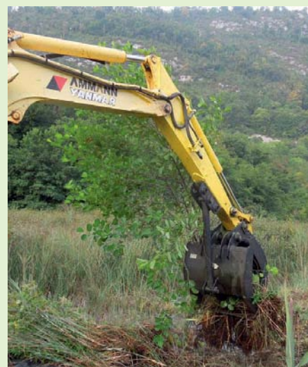
Exemple d'arrachage d'arbustes (bourdaine) avec une pince montée sur une pelle mécanique. Les racines sont enlevées avec un impact limité sur le sol.
