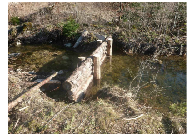
Exemple de renfort de berge en bardage rustique
