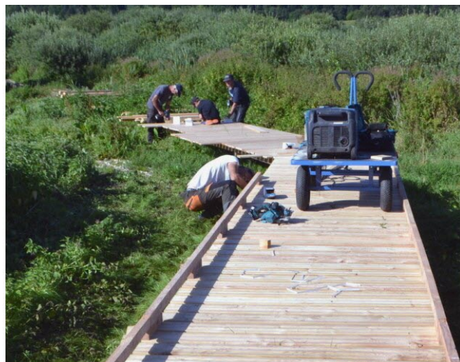
Les travaux d'installation du sentier sur pilotis de près d'un kilomètre de longueur avancent. Photo Progrès /Guy DOMAIN
